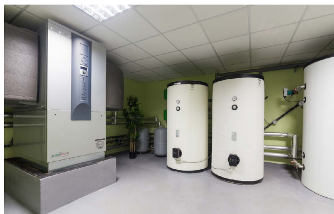
Rekonstrukce bytového domu, vnitřní systém vzduch/voda
