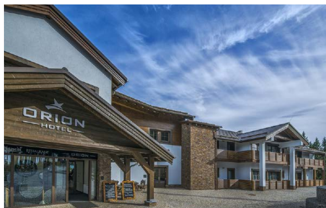
Hotel Orion, Krušné hory, vnitřní systém vzduch/voda
