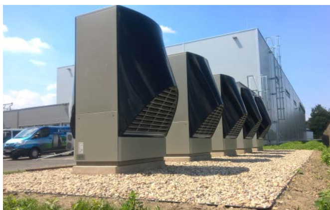
Průmyslová hala, venkovní systém vzduch/voda
